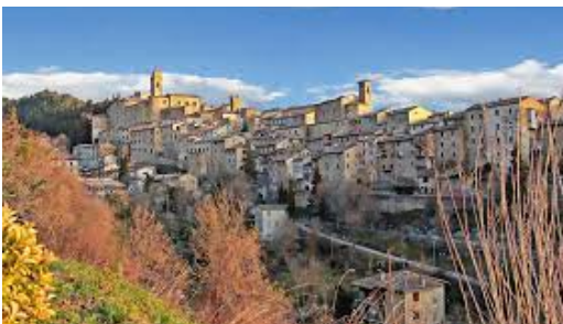
SERRA SAN QUIRICO, LE COPERTELLE
